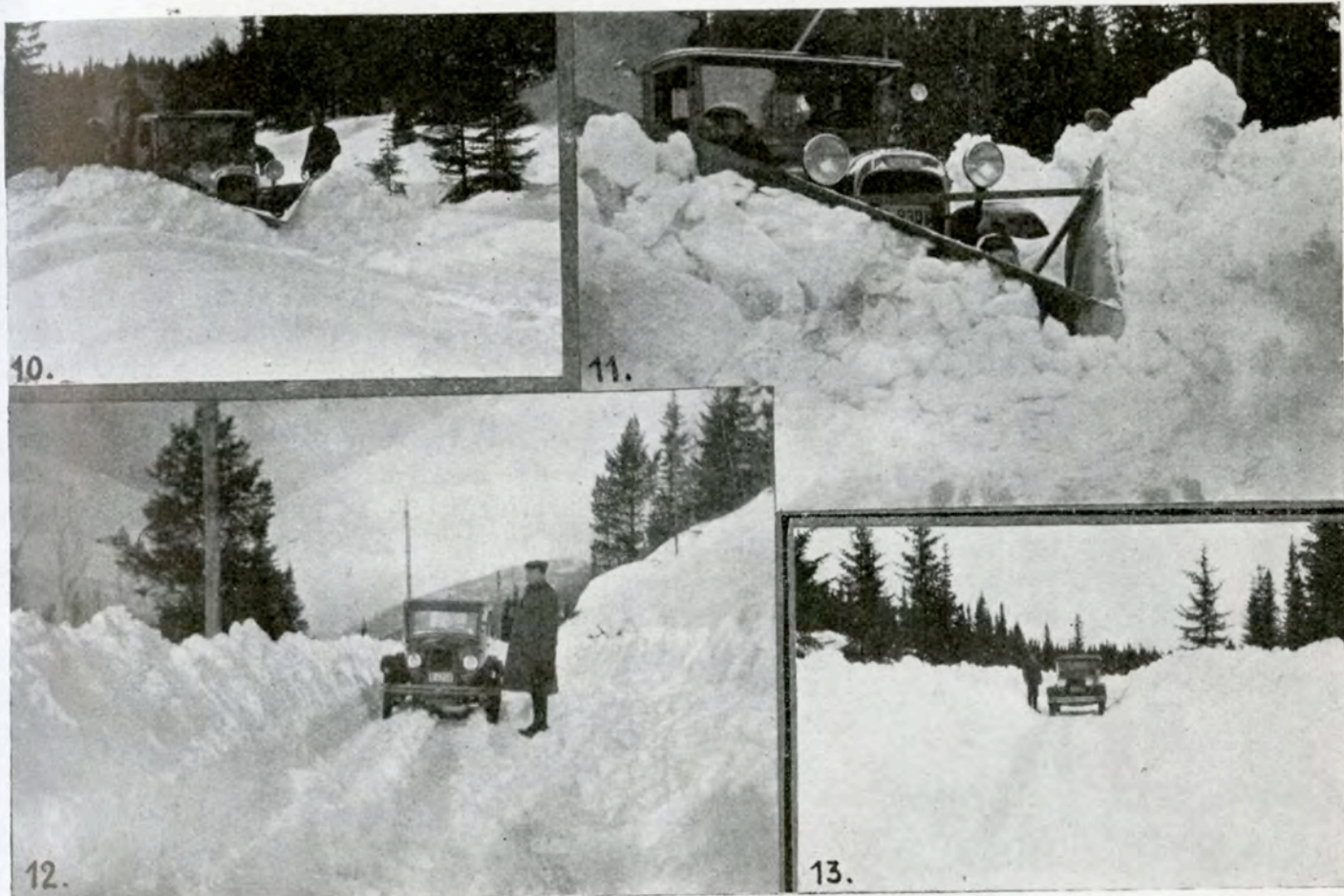
Fig. 11. Opbrytning av tilkjørt veibane — den største påkjenning.
